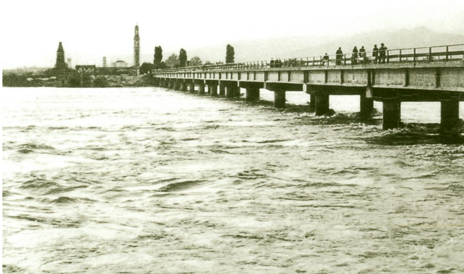
Figura 7. Il Brenta durante l'evento del 4-6 novembre 1966, in corrispondenza del ponte che collega Nove a Cartigliano (tratto da: "Nove in bianco e nero").
